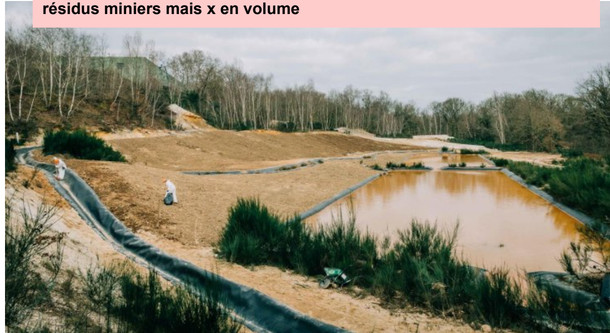
Lagune de décantation à St Pierre Montlimart en 2021 La mine d'or a cessé son activité en 1952
